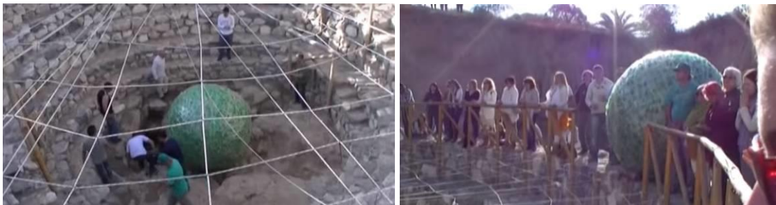
El “Átomo” de Corsi es colocado sobre El Pozo de Luz
